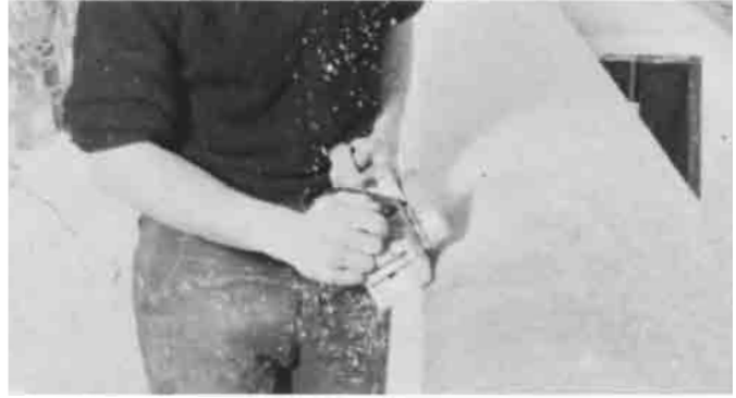
Bild 4.5 – Elektrische Hobelmaschine, hier für das Glätten eines Profilmastes benutzt (Fabr. Skil).
