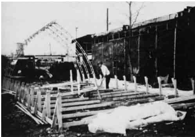
Bild 4.14 – Aufstellen der Bögen für einen Bauschuppen.
