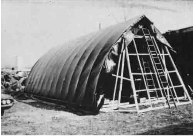
Bild 4.17 – Die Plastikfolie wird über die Rahmen gespannt.
