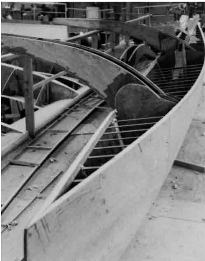
Bild 23.26 – Unterzüge für I-Träger-Decksbalken sind mit der Unterkante der Balken verleimt. Die Stege der I-Träger-Decksbalken werden auf die Unterzüge geleimt. Sie werden so aussehen, wie in Bild 23.25.
