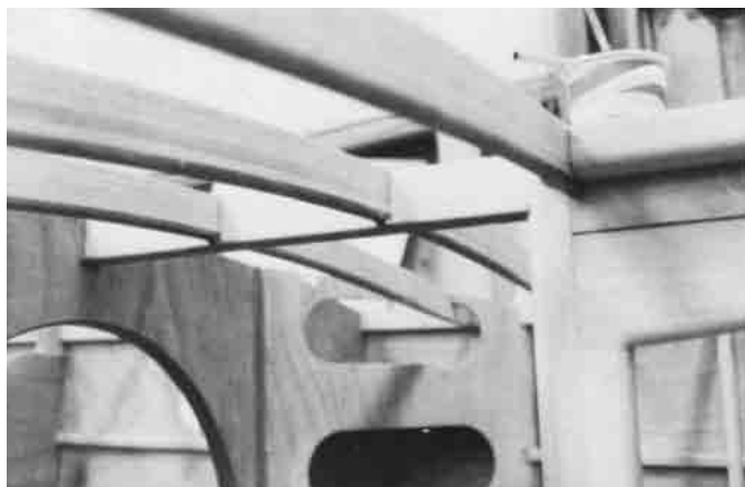
Bild 25.10 – Lamellierte Decksbalken mit Auffütterungsstücken und Hartholzkappe entlang der Mittellinie. Rechts befinden sich Auffütterungen und Stütze für auf dem Deck stehenden Mast.
