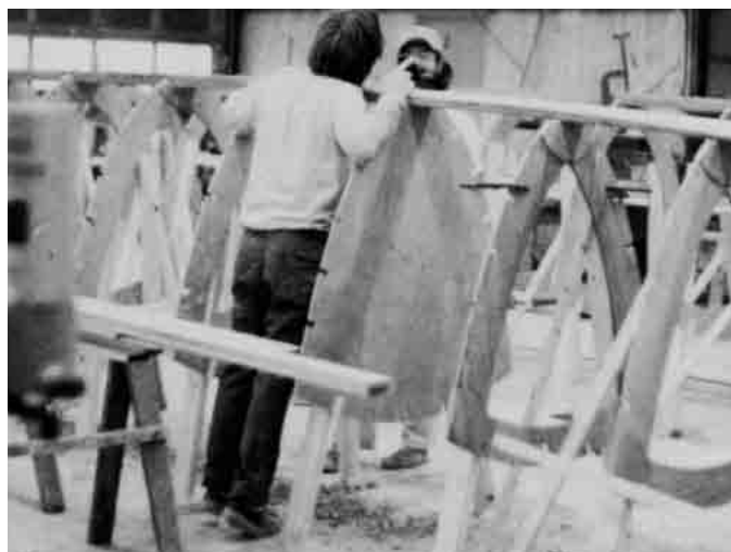
Bild 25.1 – Rahmenspannen und Decksbalken in der Helling.
