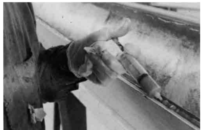
Bild 9.17 – Eine Spachtelkehle wird mit einer Einmal-Spritze aufgetragen.
