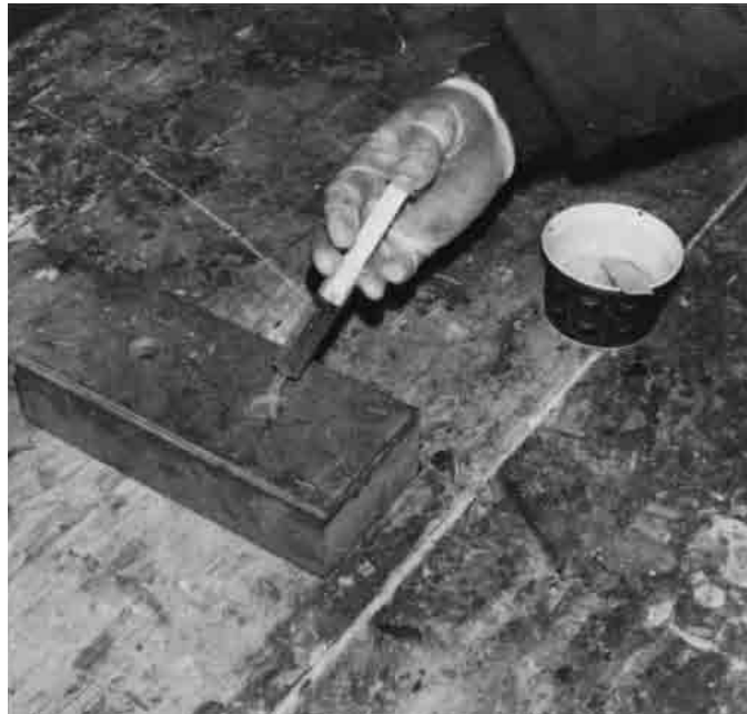
Bild 26.8 – Zum Auffüllen einer übergroßen Bohrung werden Spritzen verwendet.
