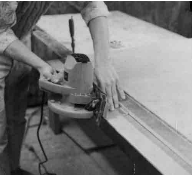
Bild 10.9 – Sperrholzplatte mit angeschärfter Kante, hergestellt mit Handkreissäge und Schäftungsansatz.
