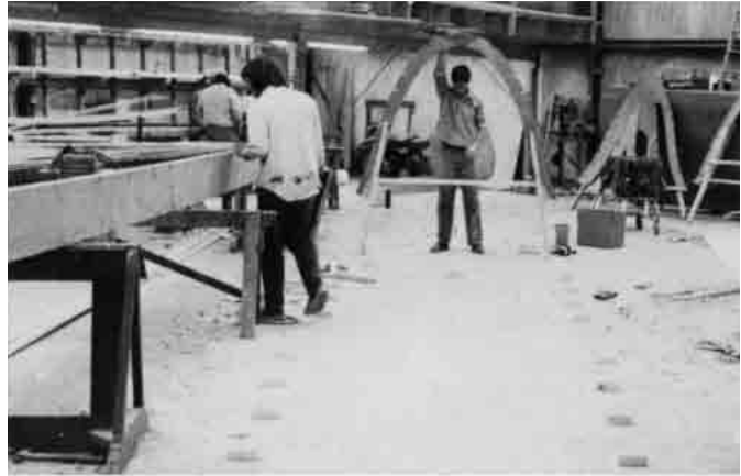
Bild 15.4 – Aufstellen des ersten Rahmens. Man erkennt die Fußblöcke auf dem Boden.
