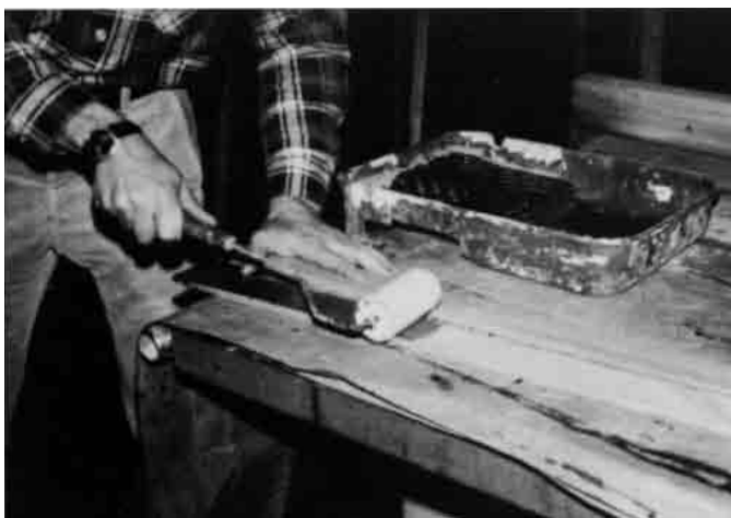
Bild 10.3 – Auftragen des Klebers auf die angeschrägte Fläche.
