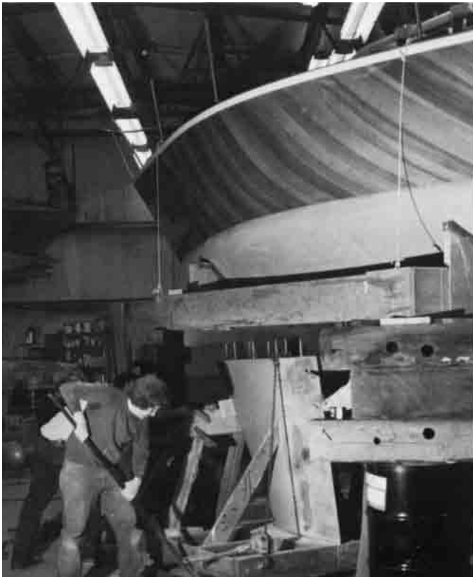
Bild 26.21 – Einfahren eines 4,5t-Kiels auf einem speziell angefertigten Montagegestell. Der Kiel kann geringfügig von einer zur anderen Seite oder vor- und zurückgerutscht werden.
