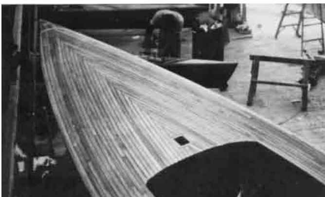
Bild 25.32 – Decksbeplankung und abschließende Schleifarbeiten fertig. Man beachte das Fischgrätmuster, wo sich die Planken in der Bootsmittle treffen. Man beachte außerdem, daß das Teakholz erst einige Zentimeter innerhalb der Deckslinie anfängt und von lackierten Leibhölzern aus dekorativen Zwecken eingerahmt wird.
