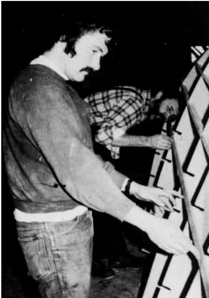
Bild 21.7 – Straken der Spanten einer Längsspanthelling.
