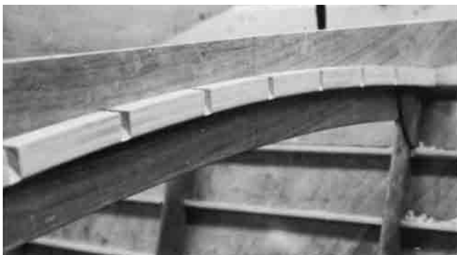
Bild 25.8 – Dreieckige Kerben wurden in diesen lamellierten Decksbalken vor der Verleimung mit dem Sperrholzspant geschnitten. Die Decks längsstringer waren danach leicht einzubauen.
