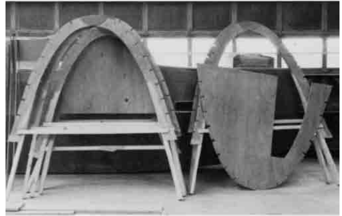
Bild 14.10 – Die Rahmenspannten sind fertig zum Aufstellen. Stützen und Querriegel sind schon angebracht. Die Rahmen sind vorbeschichtet und zeigen die Ausklinkungen für die Stringer.
