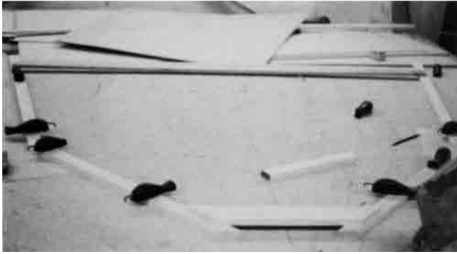
Bild 14.4 – Zupassen und Montage eines Rahmens für den Doppel-Knickspant-Rumpf eines Trimarans.
