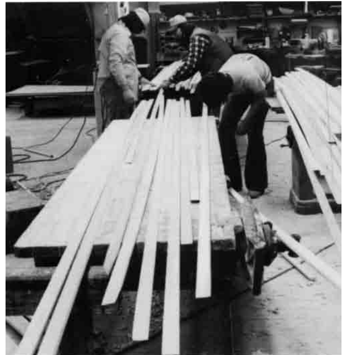
Bild 10.5 – An beiden Enden angeschrägte Stringer werden zum Verleimen und Zusammenpressen vorbereitet. Die Längen sind so zusammengestellt, daß die Schäftungen dicht beieinander liegen, um Schraubzwingen zu sparen.
