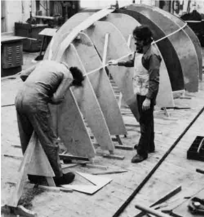
Bild 16.5 – Die Kiel/Steven-Einheit wird in das Mallspanten-Gerüst der 9,75 m langen HOT FLASH eingefügt. Die Mallspanten sind ausgeklinkt, so daß der Kiel paßgerecht mit den Mallen abschließt. Der Steven wird durch einen eigenen Fußblock gehalten.
