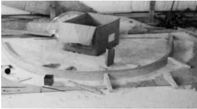
Bild 9.5 – Holzklötze sind auf den Boden geschraubt, um das Bauteil in die gewünschte Form zu bringen. Die Schraubzwingen rechts oben werden für die Probe und für das spätere Verleimen benutzt.
