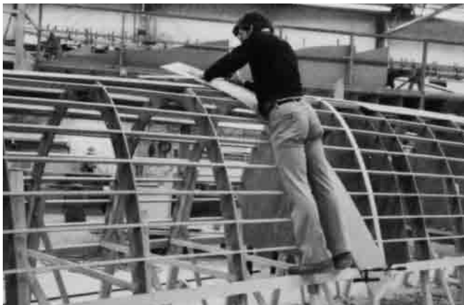
Bild 21.1 – Helling des Haupttrumpfes der ROGUE WAVE mit eingebauten Stringern, fertig zum Beplanken.
