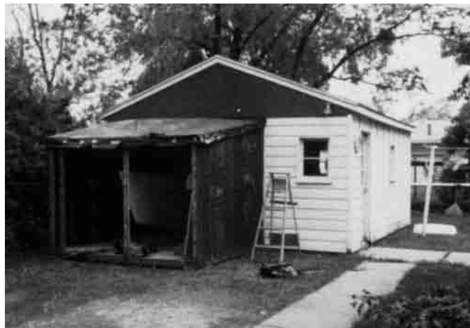
Bild 4.13 – Garagen-Anbau (Art Briggs)
