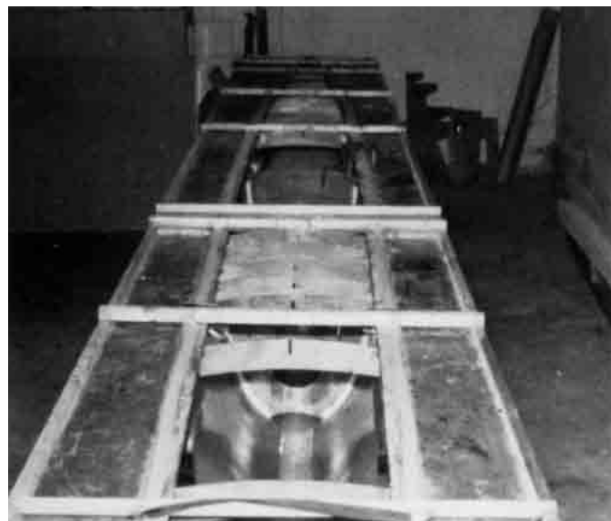
Bild 23.24 – Einbau von Decksbalken bei einem Tomado-Rumpf. Man beachte die Kerbungen für einen Stringer entlang der Mittellinie.
