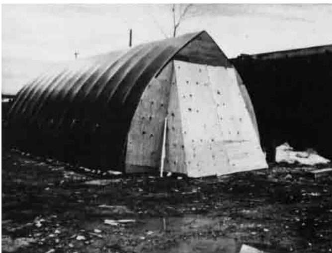
Bild 4.18 – Fertiger Schuppen. Die Stirnwände aus Sperrholz geben der Konstruktion zusätzlichen Halt.
