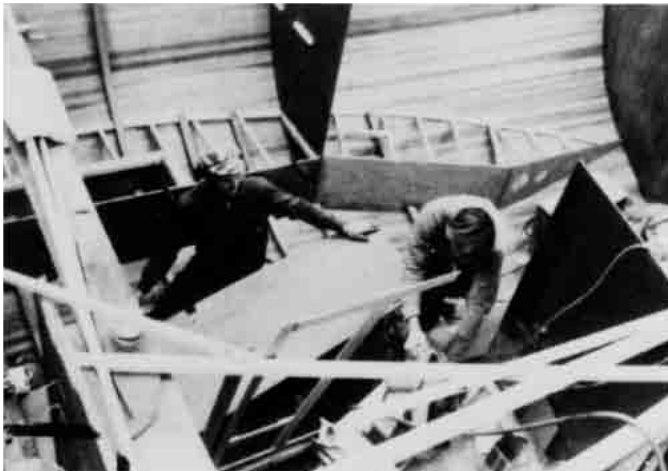
Bild 24.1 – Sechs Kojen, Pantry und Schapps, verleimt mit der Innenseite der Außenhaut, tragen zu einer bedeutend steiferen Struktur bei.
