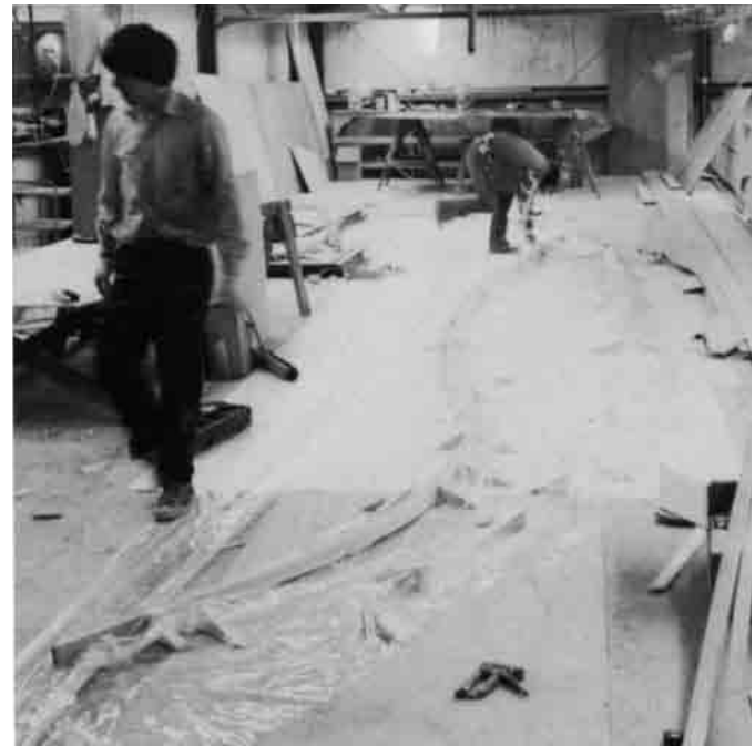
Bild 9.2 – Das Lamellieren eines großen Bauteils für den Querträger eines Trimarans mithilfe von Knien, die auf dem Boden befestigt sind.
