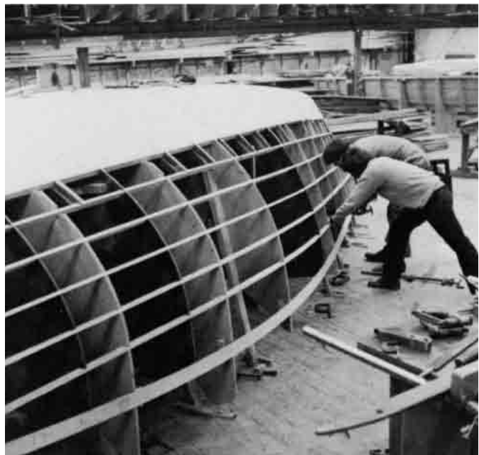
Bild 21.12 -Plazierung der Balkweger und seitlichen Stringer nach Installation der lamellierten Bodenwangen, der Auf-fütterungen und der ersten Schicht der Sperrholzbeplankung auf dem Unterwasserschiff.
