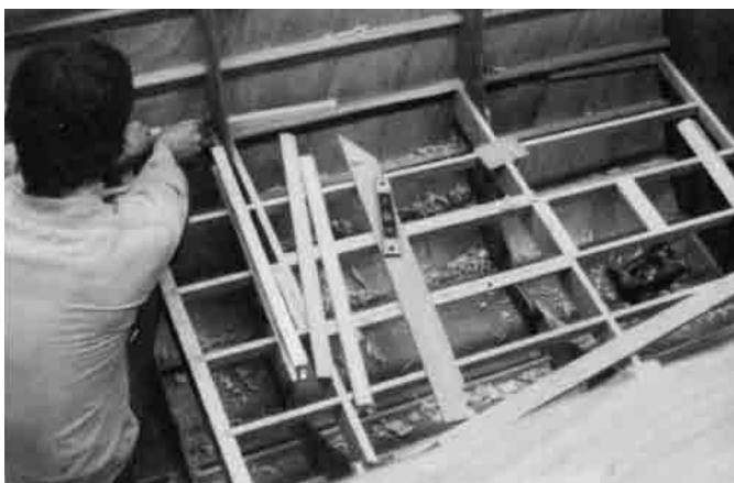
Bild 24.18 – Einbau des Rahmenwerks des Kajütbodens der ROGUE WAVE. Die Konstruktion stützt sowohl die Außenhaut als auch den Fußboden.
