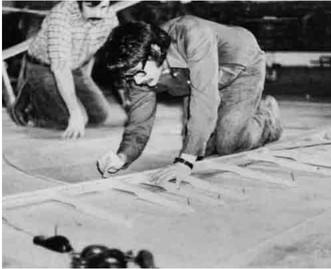
Bild 14.3 – Die Decksbucht eines Schotts wird vom Schnürboden auf die Sperrholzplatte übertragen.
