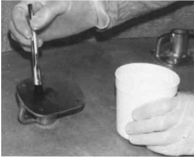
Bild 26.11 – Auftragen von Harz auf die Klebefläche.
