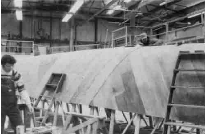
Bild 19.18 – Anbringen der zweiten Beplankungsschicht.
