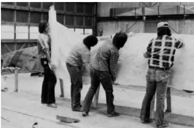
Bild 12.2 – Eine Polypropylen-Folie wird nach der nassen Methode am Rumpf eines 13,7 m langen Auslegers angebracht.
