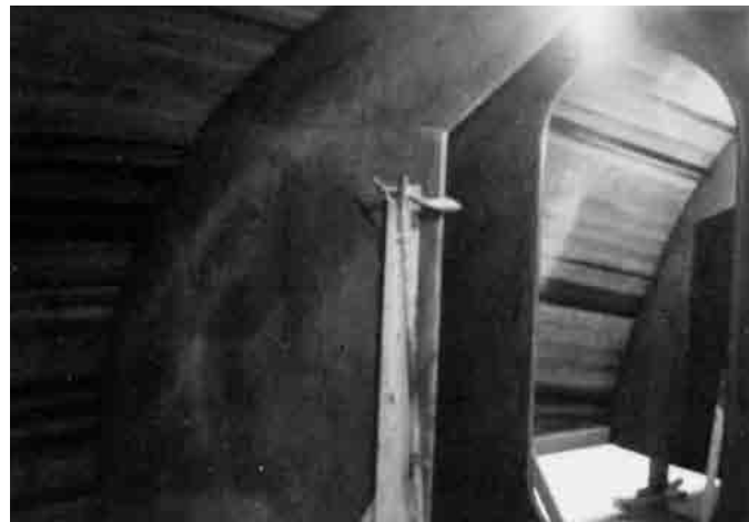
Bild 20.8 – 12,80 m-Rumpf, aus dem die Mallspanten entfernt sind. Der Rumpf wird von den festen Schotten getragen, die in der Helling aufgestellt wurden. Man beachte den sauberen Innenraum, in dem die Arbeit weitergehen kann, während die Außenseite fertiggestellt wird.
