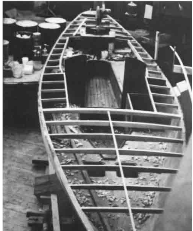
Bild 25.29 – Deck einer 7.90 m LUDERS 16 mit Deckbalken, fertig für die Sperrholzabdeckung.
